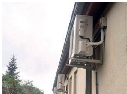
Chauffage de la salle polyvalente avec la pose de cinq unités de climatisation réversible en intérieur.
